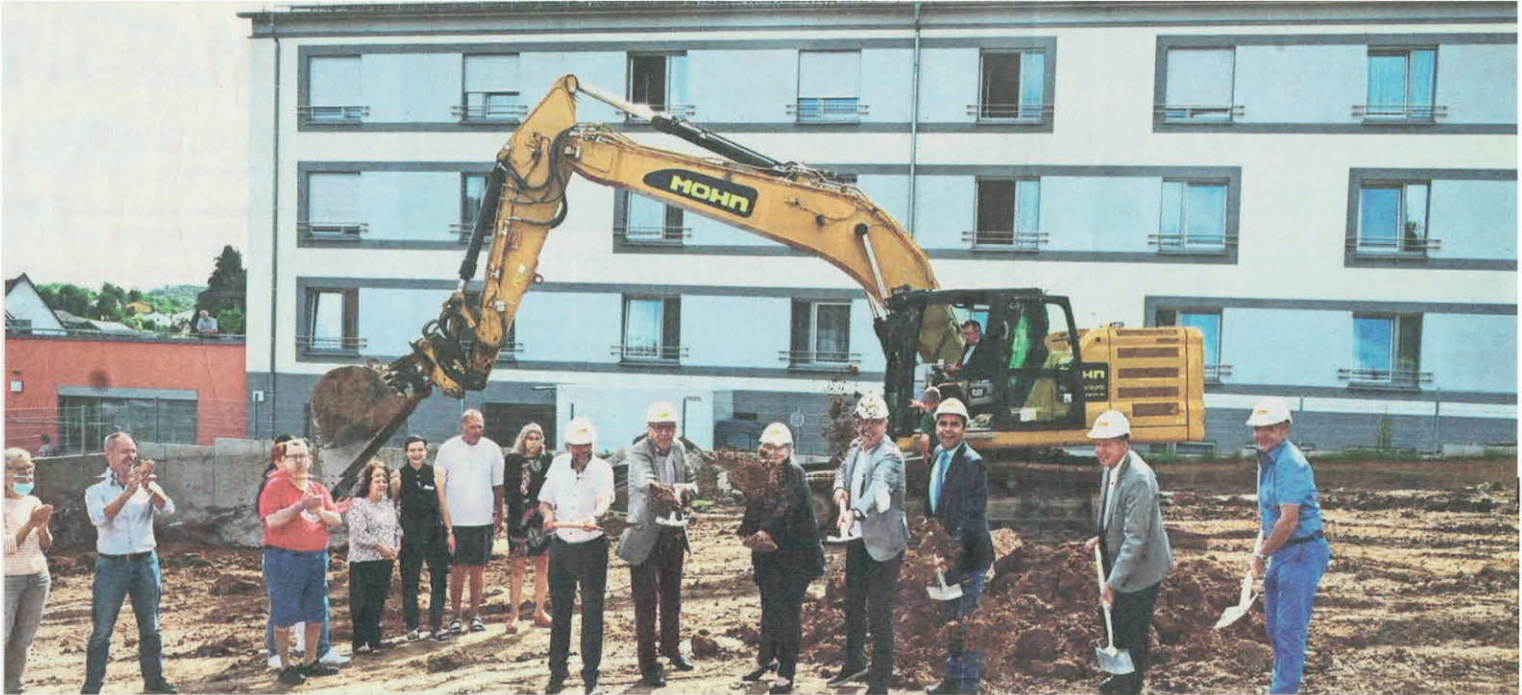
Die Bagger sind bereits seit wenigen Tagen im Einsatz, doch der Spatenstich darf nicht fehlen. Der Bau der Heim-Erweiterung in Winzerhausen nimmt nun Fahrt auf.
